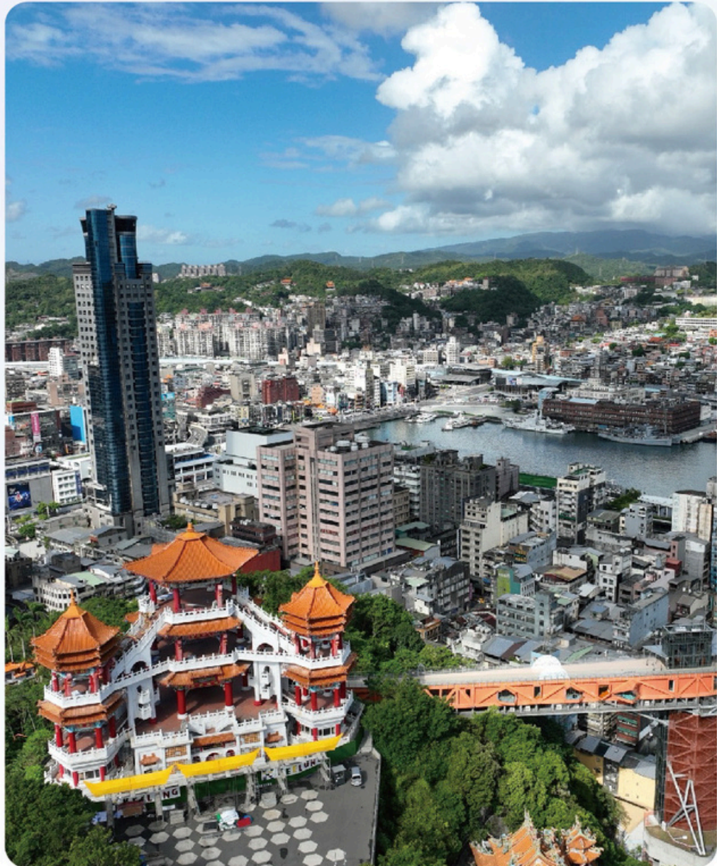
基隆塔 基隆新地標 高空俯瞰山海城
